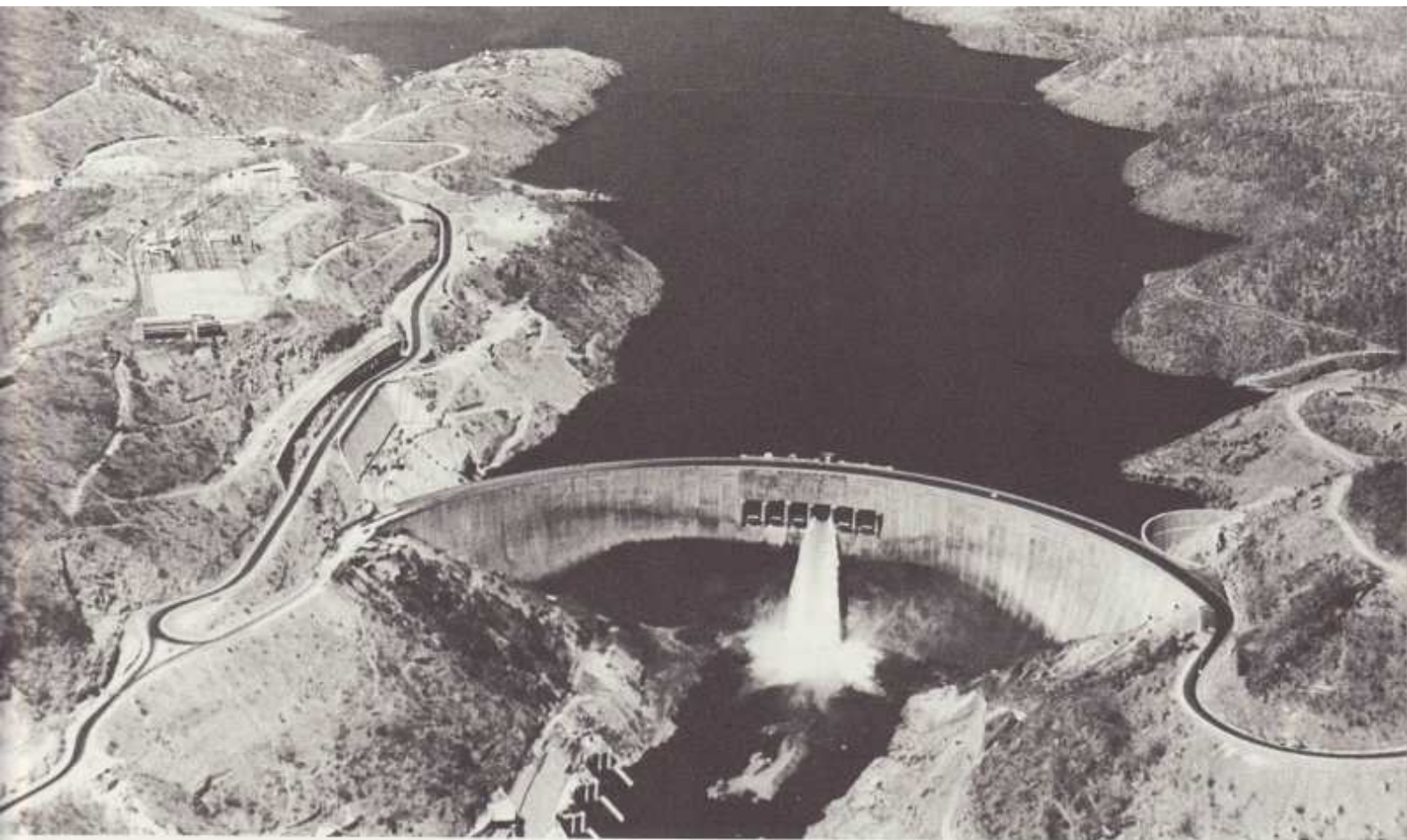
Due aspetti della grande diga ad arco di Kariba, sul fiume Zambesi in Africa, una delle piú imponenti costruzioni di questo tipo, alta 128 metri e lunga 580, realizzata fra il 1955 e il 1959 da un'impresa italiana.
